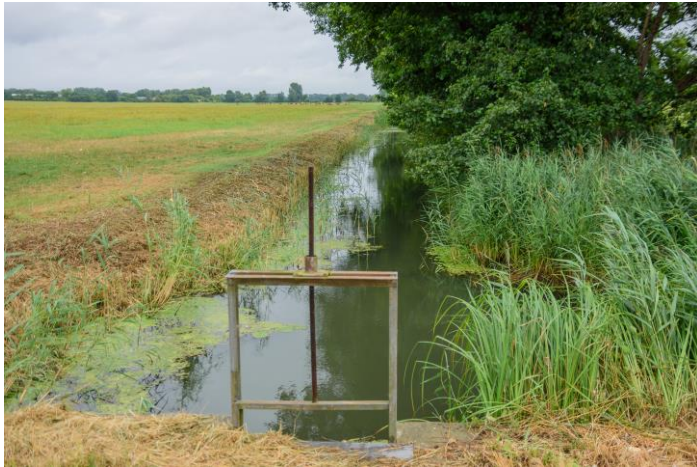
Stauanlage im Spreewald; Foto: Michael Trepel
